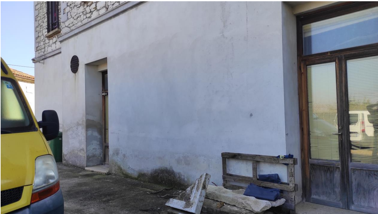
Hier soll eine Überdachung für den Handwerkkunterricht gebaut werden.
